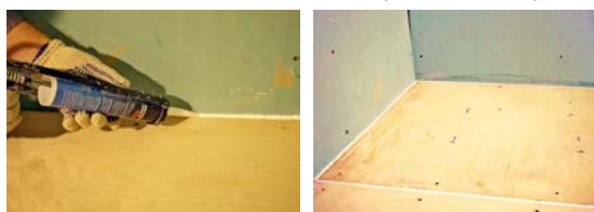
Стыки по периметру заполняются герметиком «Вибросил»
