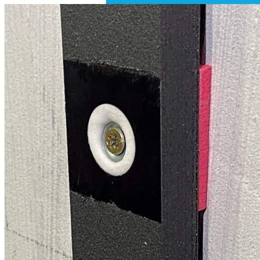
Внимание! Головка винта утапливается в поверхность вибрузла не более чем на 1-2 мм
